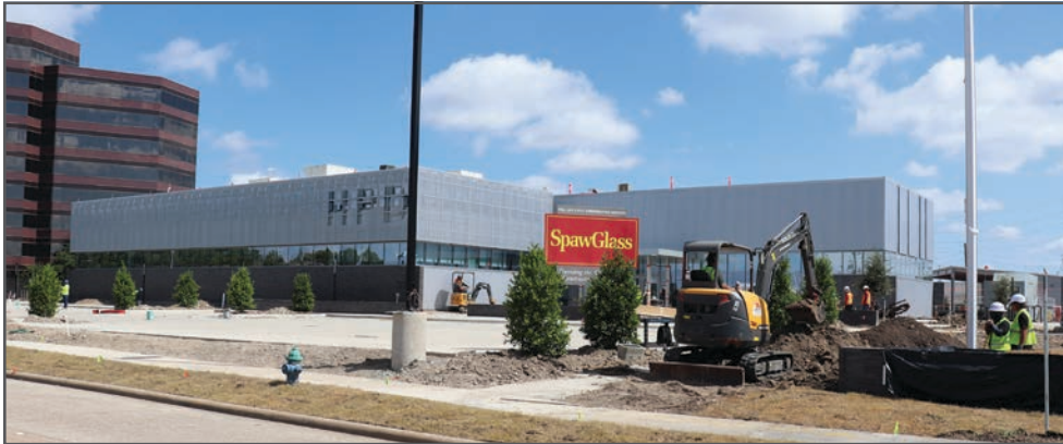
La nueva comisaría, de 27,000 pies cuadrados, albergará a la División North Belt y a otras unidades del HPD que prestan servicio en la zona.
